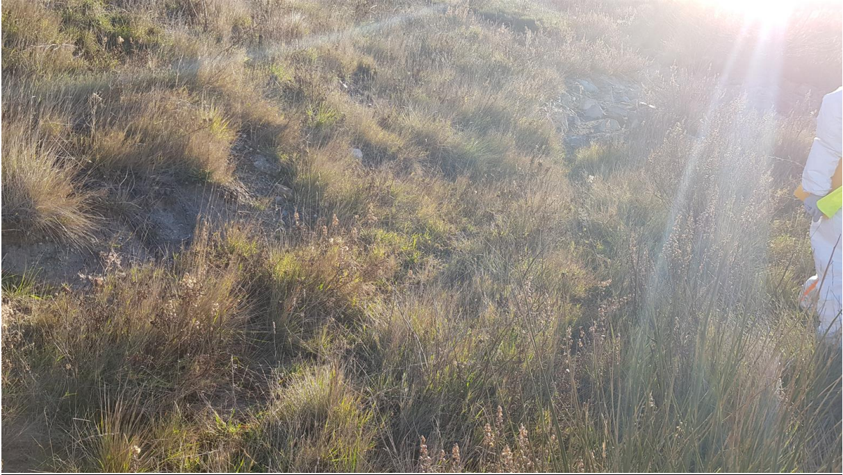
Point d'observation 6a : zone ou le fil d'eau du fossé doit être reprofilé
