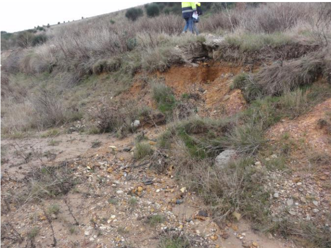
Point d'observation 3 : Fossé à recalibrer avec dépôts de stériles avec stagnations d'eau
