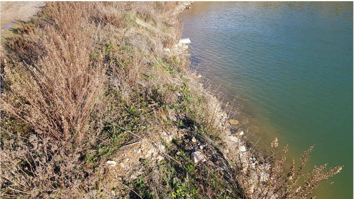
Point d'observation 8 : 4 zones d'érosion décimétriques sur la digue entre les bassins 3 et 4 observées en 2018 n'ont pas évoluées en 2021
